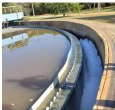
Foto 4 – Formação de espuma no efluente do decantador
