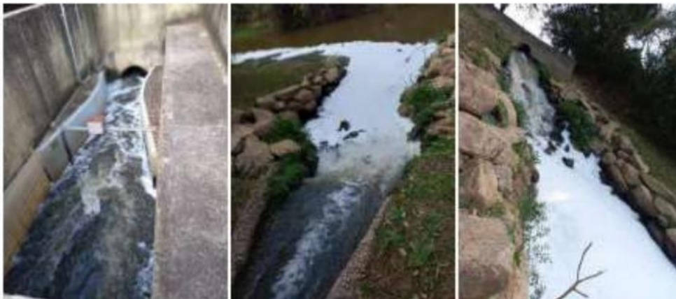
Fotos 11, 12 e 13 – À esquerda vista da Calha Parshall e vistas do local de lançamento do efluente ao corpo receptor, sendo observada a formação de grande quantidade de espuma.
