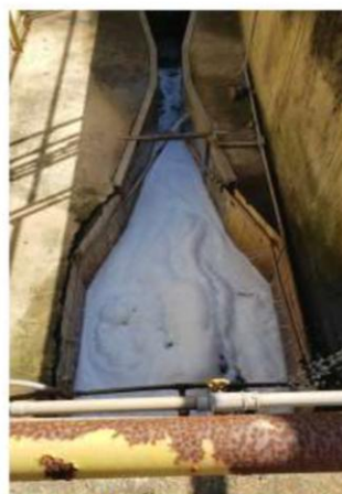
Foto 5 – Efluente final da estação com presença de espuma
